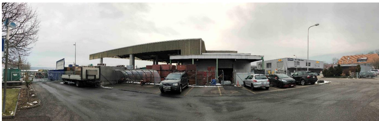
Abbildung 2: Sicht in Richtung Baufeld A1 / B1
