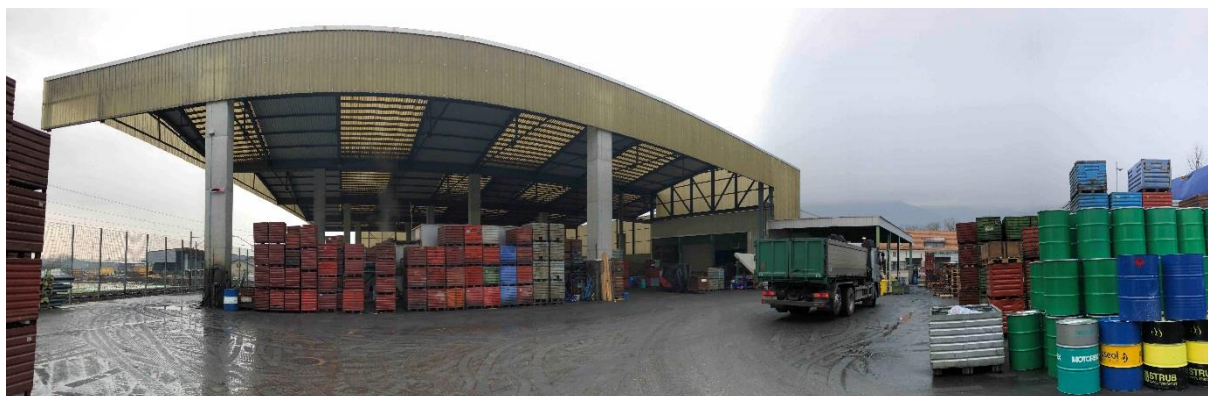
Abbildung 3: Sicht in Richtung Baufeld A1 / B1
